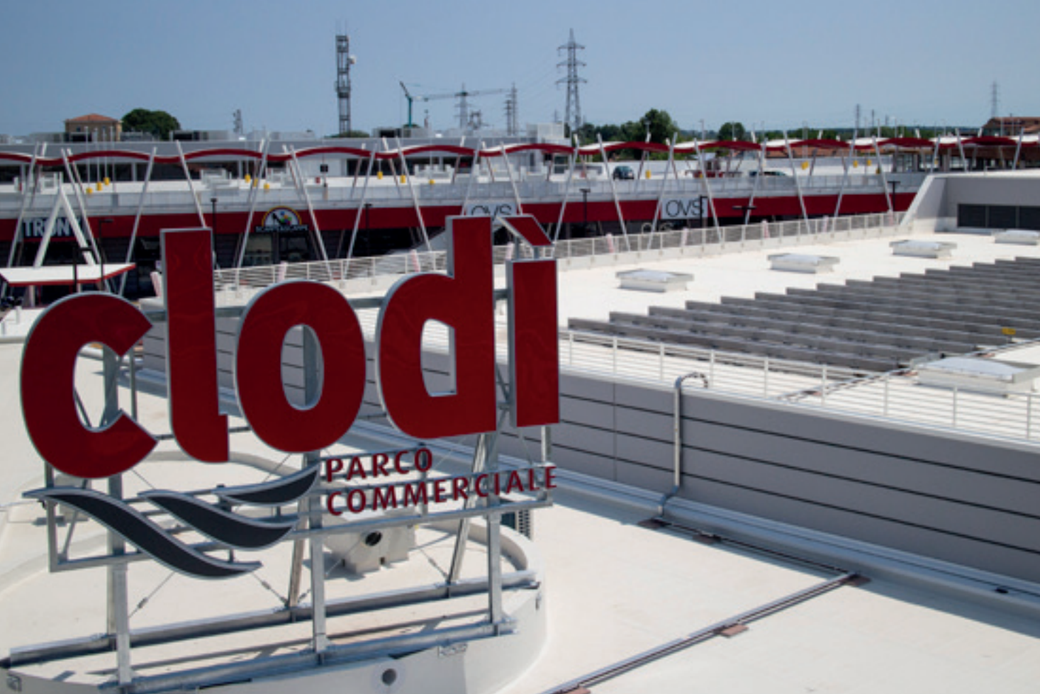
Chioggia (VE) Clodi Impianto fotovoltaico
