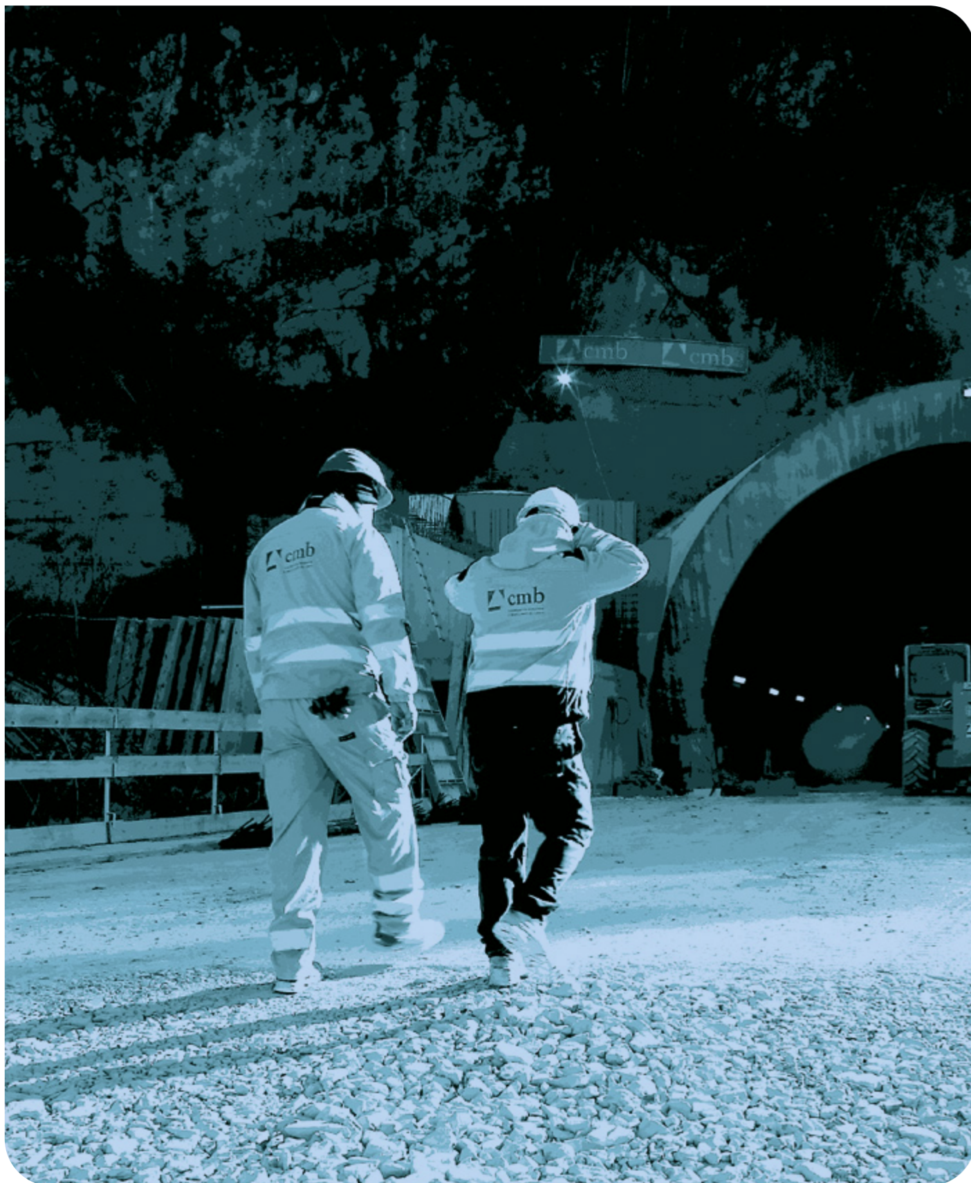
📷 Personale presso il cantiere della tangenziale di Vittorio Veneto, 2018
